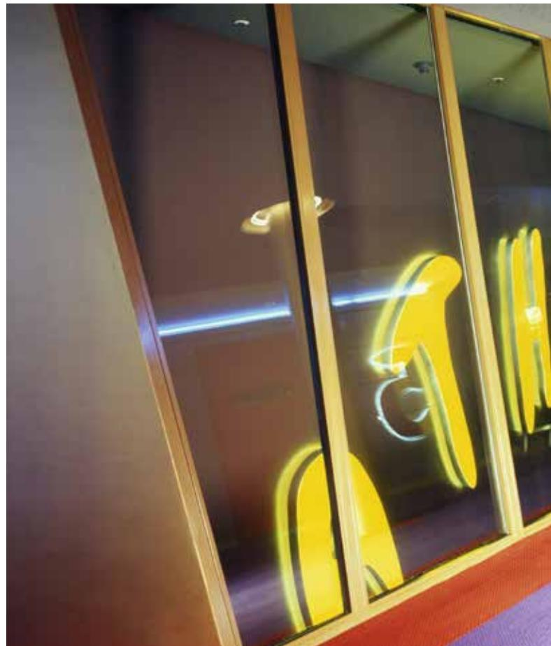
Ein wesentlicher Faktor von FIRESWISS FOAM, dem Brandschutzglas der Klassifizierung EI, ist der zusätzliche Schutz vor gefährlicher Hitzestrahlung. Durch ein so genanntes Hitzeschild erfolgt eine Brandabschnittsbildung, die den Helfern und Einsatzkräften ein gefahrloses Passieren der Flucht- und Rettungswege ermöglicht. Je nach Anforderung und verwendetem Glastyp kann eine Feuerwiderstandsdauer von bis zu 120 Minuten erreicht werden.
