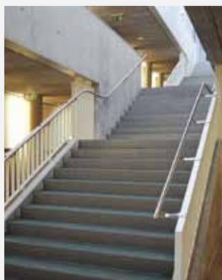
Gerade Treppen sind in Einfamilienhäusern oder innerhalb einer Wohnung möglich. In Mehrfamilienhäusern sollten sie nur eingesetzt werden, wenn pro Geschoss ein Zwischenpodest erstellt wird, wodurch die Sturzlänge verkürzt wird.
