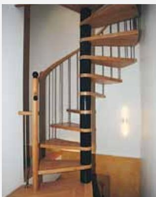
Die Spindeltreppe sollte nicht als Haupttreppe in einem Wohnhaus eingesetzt werden. Bei einer Breite des Treppenlaufes von 80 cm kann nur etwas mehr als die Hälfte begangen werden und der Transport von sperrigen Gütern ist erschwert. Die Verwendung als Erschließung von Galerien ist möglich.
